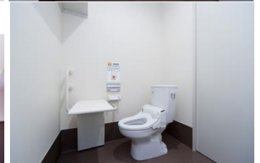
▲共同生活室の標準トイレ。「前傾姿勢支持テーブル」を設置しています。
