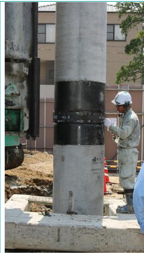
▲杭の接合部分。
